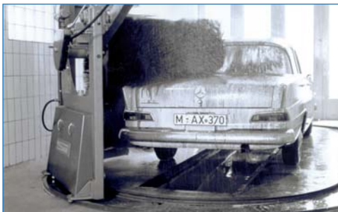
Así empezó todo: El primer sistema de lavado automático de Wesumat todavía giraba alrededor del vehículo.
